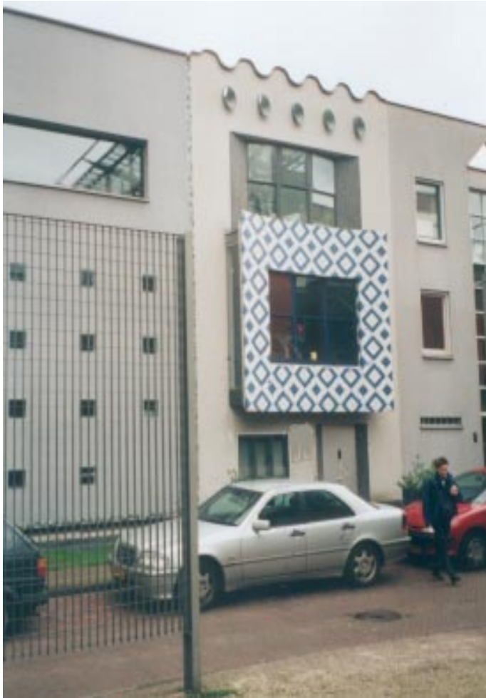
Passivenergiehaus - Wohnhaus, Delft Niederlande, April 2000
